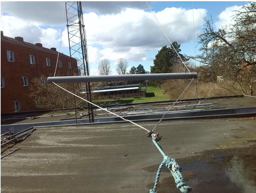
Billede 8 – Ende af dipol med isolator
