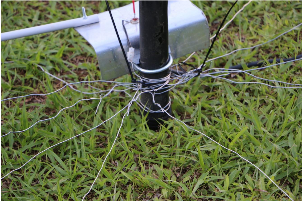
Jordnet til vertikal antenne
